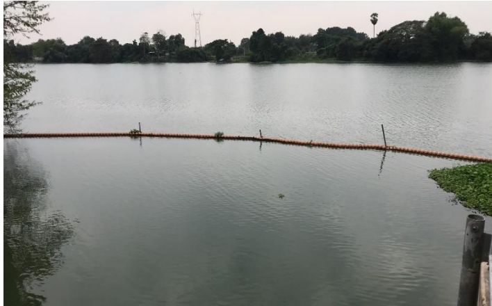
Log boom กั้นด้านนอกเพื่อกันสวะหรือวัชพืชที่ปนมากับน้ำ
